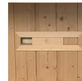
Camino per aerazione Ventilation grid
